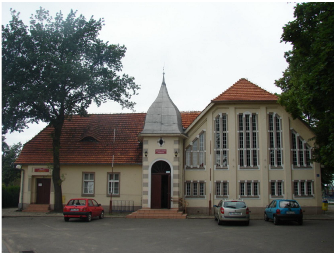
Fotografia nr 1 - elewacja wschodnia
