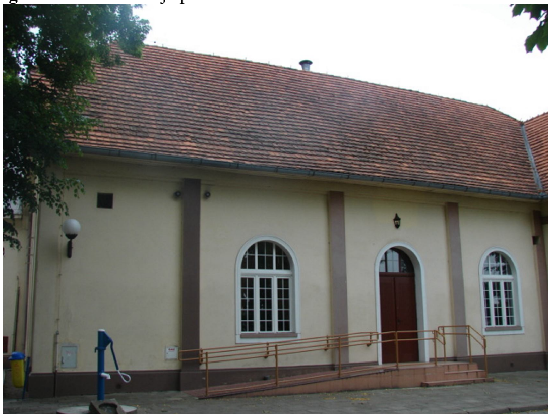
Fotografia nr 3 - elewacja północna
