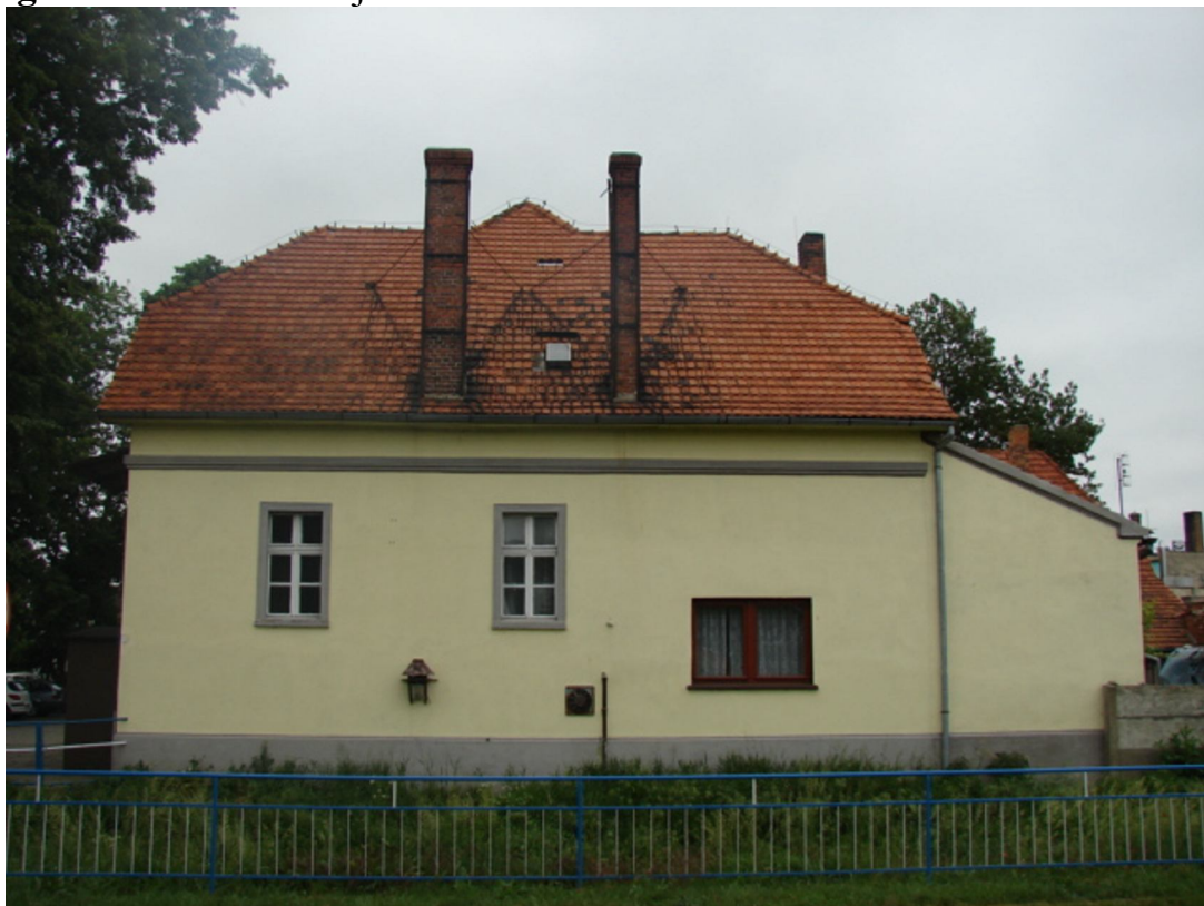
Fotografia nr 2 - elewacja zachodnia
