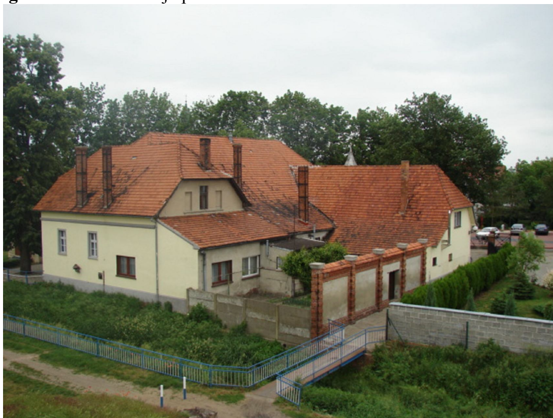
Fotografia nr 4 - elewacja południowa
