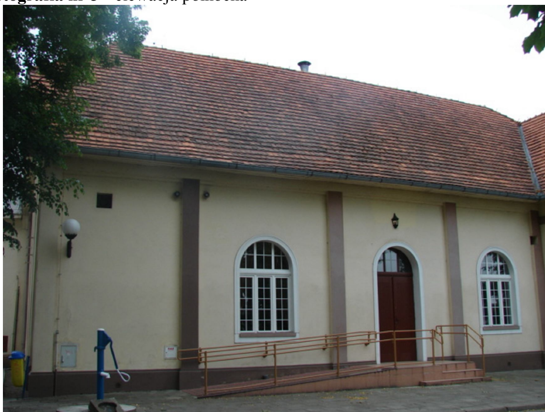
Fotografia nr 3 - elewacja północna
