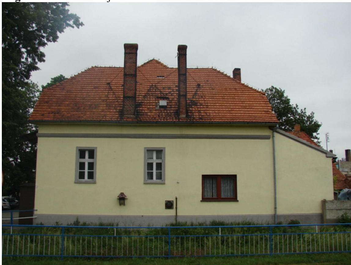
Fotografia nr 2 - elewacja zachodnia
