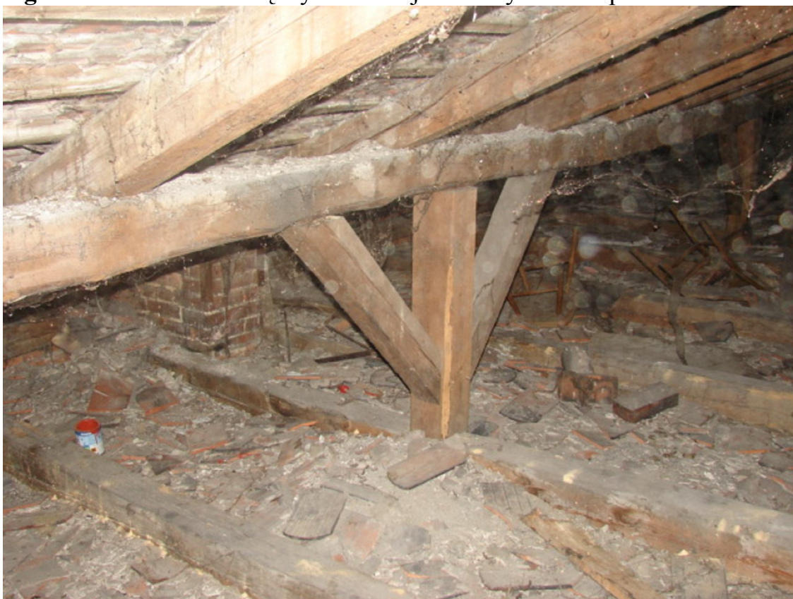
Fotografia nr 7 - widok więźby dachowej nad korytarzem i pom. wc
