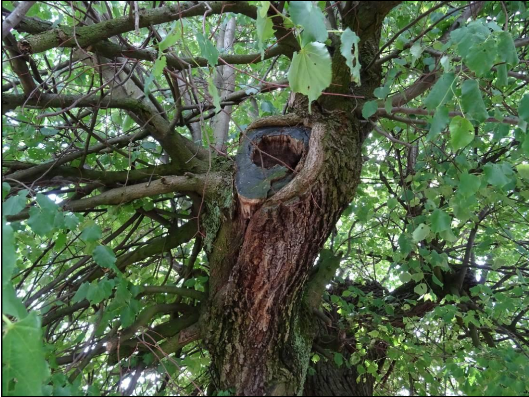
Fot. 16. Wyróżnienie w konarze powstałe w wyniku rozłamania lub nieodpowiednio prowadzonych cięć. Liczne wilki wyrosłe z konarów wymagają redukcji (fot. P. Andrzejczuk).
