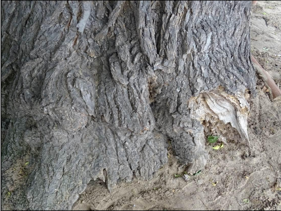
Fot. 7. System korzeniowy strony południowej pnia z widocznymi naderwanymi nabiegami korzeniowymi (fot. P. Andrzejczuk).
