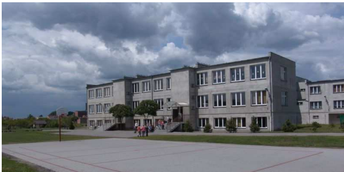
Rysunek nr 33. Budynek Szkoły Podstawowej im. M. Konopnickiej w Miejskiej Górze, ul. M. Konopnickiej 14 Źródło: miejska-gorka.pl
